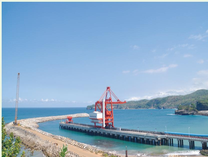
印尼巴齐丹火电工程码头项目由集团承建,施工内容包括一个煤码头和一个大物件码头水工及防波堤工程、港池疏浚工程、护岸工程、转运站等建(构)筑物以及给排水工程。东设主防波堤,西设辅助防波堤,总长度999米。港池航道的疏浚工程总规模达83万立方米。
