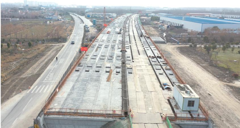
元旦之际，在盐阜2标204国道跨线桥施工现场，随着指挥员的一声哨声，架桥机缓缓地吊起一片长30米、底宽1米、顶宽2.6米、重91.5吨的预制箱梁，经过近一个小时的前移、悬停、定位、落梁、测量、调整等工序后，跨线桥最后一块预制箱梁顺利架设完成，该桥正式进入桥面系施工阶段。徐金亮 摄影报道
